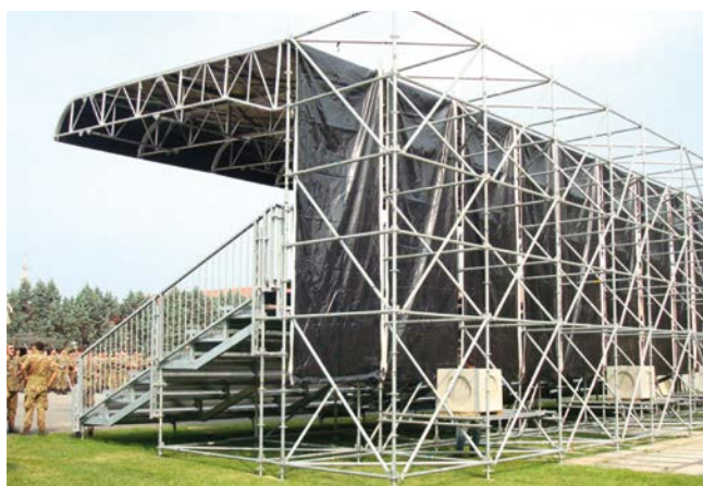
Possibilità di creare coperture a sbalzo, dimensioni da 4,70 m a 8,60 m utilizzando una specifica trave sagomata collegata a un Wall posteriore realizzato in ponteggio Multidirezionale MP per proteggere tribune, gradonate e passerelle.
