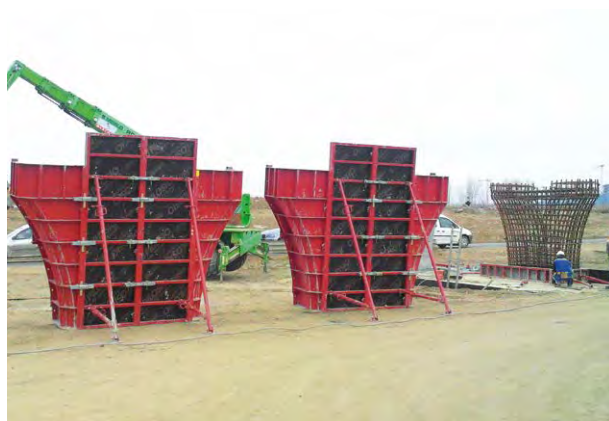
Baxcom - Bucharest Romania Applicazioni di casseforme modulari a telaio abbinate a elementi speciali in carpenteria per l'esecuzione di pile e pulvini per viadotti.
