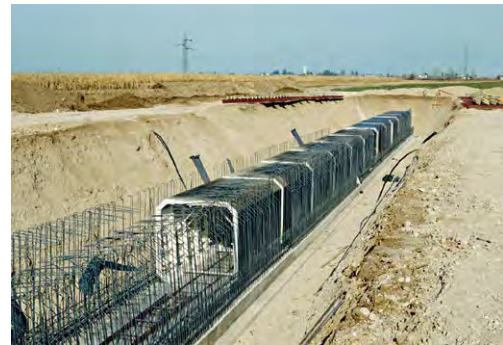
Cassaforma speciale dotata di cerniere, di dimensione 220x220 cm e lunghezza 6 m a modulo, per il getto contemporaneo dei muri verticali e della soletta della condotta. In fase di disarmo, le cerniere permettono di modificare la forma della cassaforma avvicinando le parti verticali verso l'interno e abbassando la parte superiore in modo da poter traslare tutta la struttura sotto gli altri elementi mediante un carrello su rotaie
